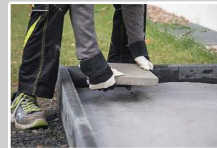
7. Lege als Basis für die Stelzlager in regelmäßigen Abständen Betonplatten auf das Vlies.
