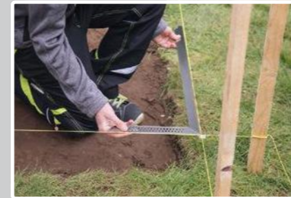
1. Beginne mit dem Einmessen und Abstecken der Terrassefläche.
