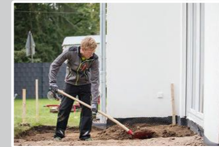
2. Die abgesteckte Fläche kann nun ausgeschachtet werden.
