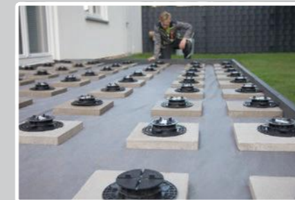
8. Stelle auf jede Platte ein Stelzlager.
