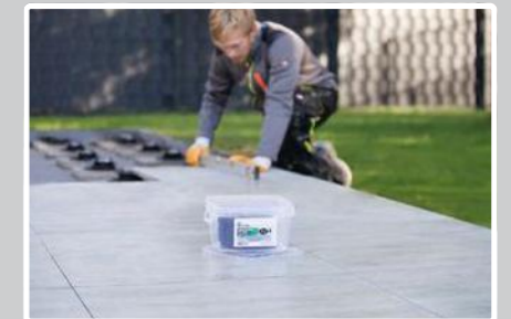
9. Jetzt kannst Du die Terrasseplatten verlegen.
