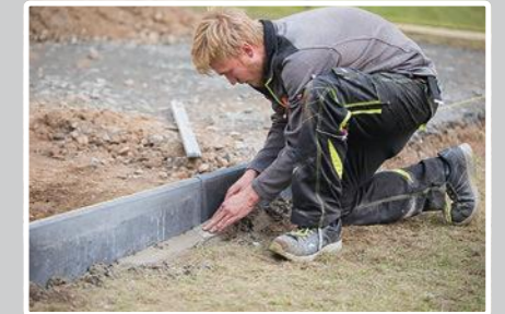
3. Setze Kantensteine zur Einfassung und Stabilisierung der Terrasse.
