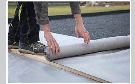
6. Verlege Vlies als Schutz gegen Unkraut auf dem Splitt.
