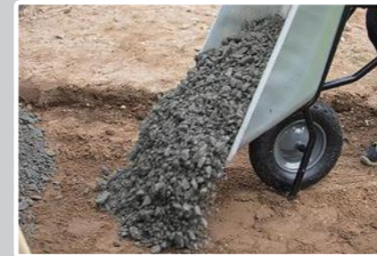
4. Bringe die benötigte Menge an Mineralgemisch ein, und verdichte diese.
