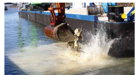
Einbringen der neuen Steinschüttung
