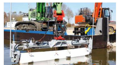
Mit Hilfe von GPS-Daten wird die Sandmatte exakt positioniert
