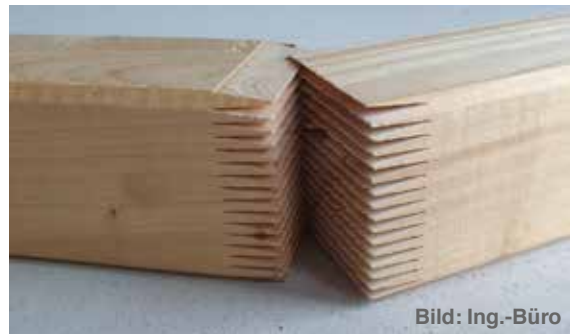
Abb. 11 Keilzinkenverbindung zum Fügen eines Endlosstranges
