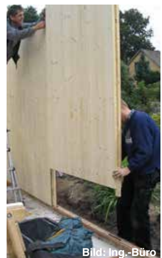
Abb. 56 Bei schmalen Wandtafeln (hier 1,25 m) kann die Verbindung mit einer Fremdfeder aus Sperrholz erfolgen (siehe Folgeseite oben, rechtes Bild). Der Überstand der Sperrholzfeder dient als Zapfen und Anschluss zur Schwelle.
