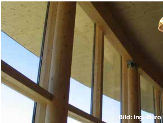
Abb. 47 Bei dieser Ausstellungshalle mit Brettsperrholzelementen wurde ein Dachüberstand von ca. 3 Metern Auskrägung hergestellt. Der Konstruktionsaufbau ist einfach.
