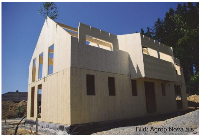
Abb. 78: Rohbau im Holzmassivbau mit Brettsperreholzelementen. Es sind alle individuellen Gebäudeformen erstellbar.
