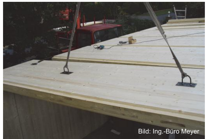
Abb. 78: Rohbau im Holzmassivbau mit Brettsperreholzelementen. Es sind alle individuellen Gebäudeformen erstellbar.
