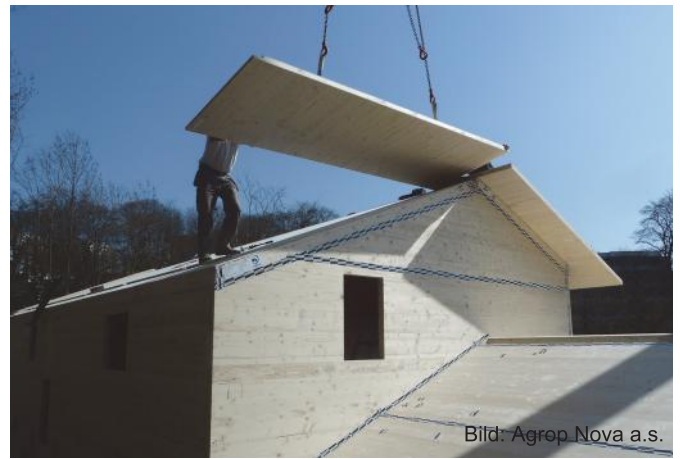
Abb. 79: Selbst Dächer können hergestellt werden.
