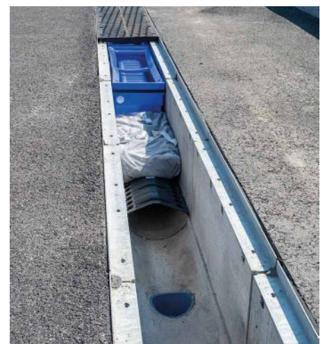
Nach der Grobreinigung in der Sedimentationsbox wird das Regenwasser in der Filtereinheit gereinigt und dann über Ablaufpunkte im Rinnenkörper abgeleitet
