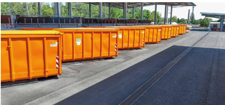
Die Rinnensystemlösung BIRCOpur® aus reinem Beton ermöglicht die umweltschonende Wasserbehandlung, -verteilung und -versickerung vor Ort
