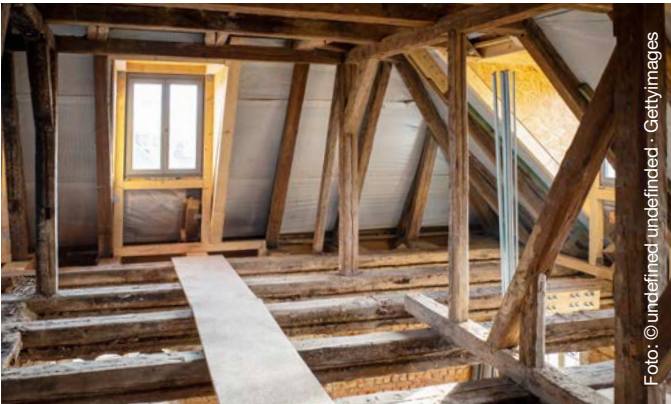
Im ersten Schritt muss die Bausubstanz genau geprüft werden, z. B. auf Schäden durch Feuchtigkeit und den Hausbock.
