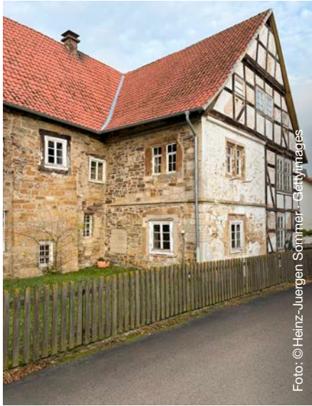
Der Denkmalschutz: eine lukrative Nische für Zimmerer und Dachdecker
